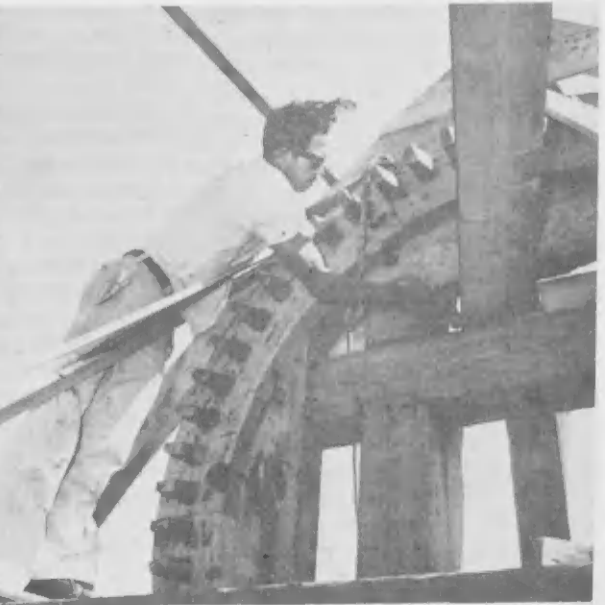
APARATONAN DI palo pisa, banda robex, probablemente parti di e mecanismo original, ta worde re-instala door di un trahador. Evidencia di e obra di man cu a bai den e mulina por worde mira na banda drechi.
